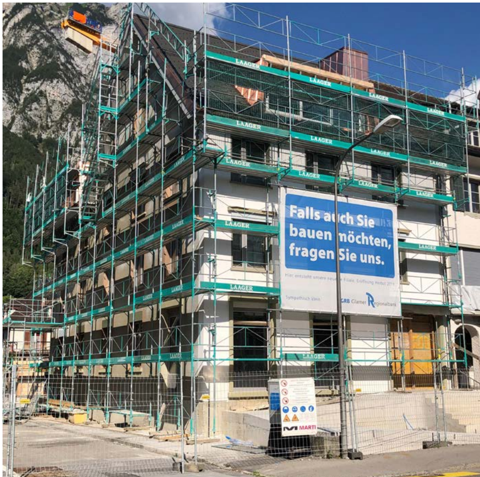
Die neue Filiale der GRB Glarner Regionalbank in Glarus nimmt Formen an.
